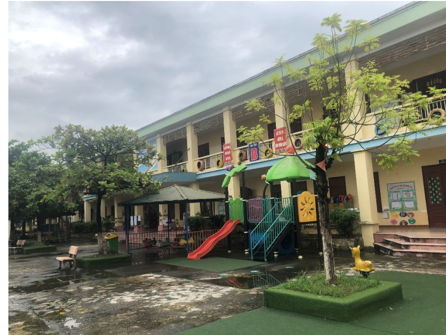
Hiện trạng nhà B
