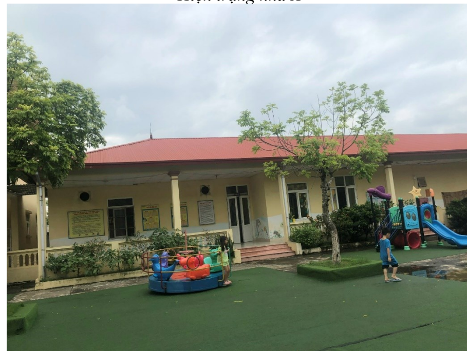
Hiện trạng nhà C
