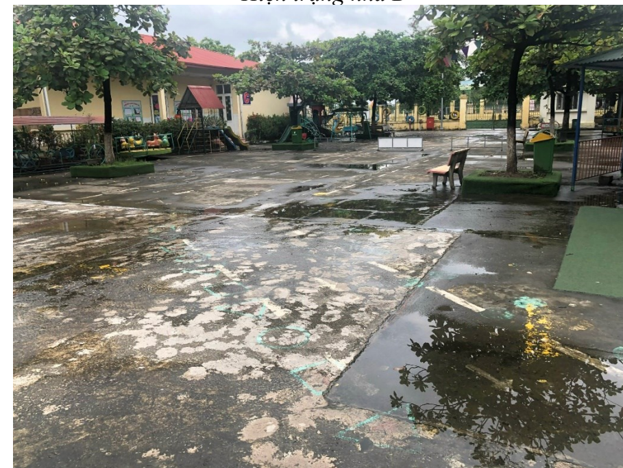
Hiện trạng hạ tầng sân vườn
